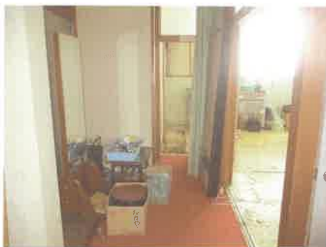
2階 配膳室付近
