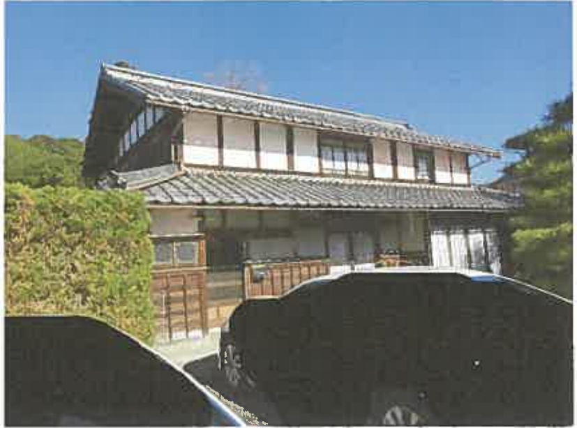
① 物件3主建物
