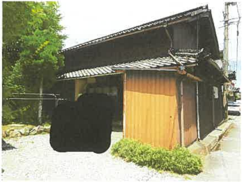
⑩ 物件5主建物
