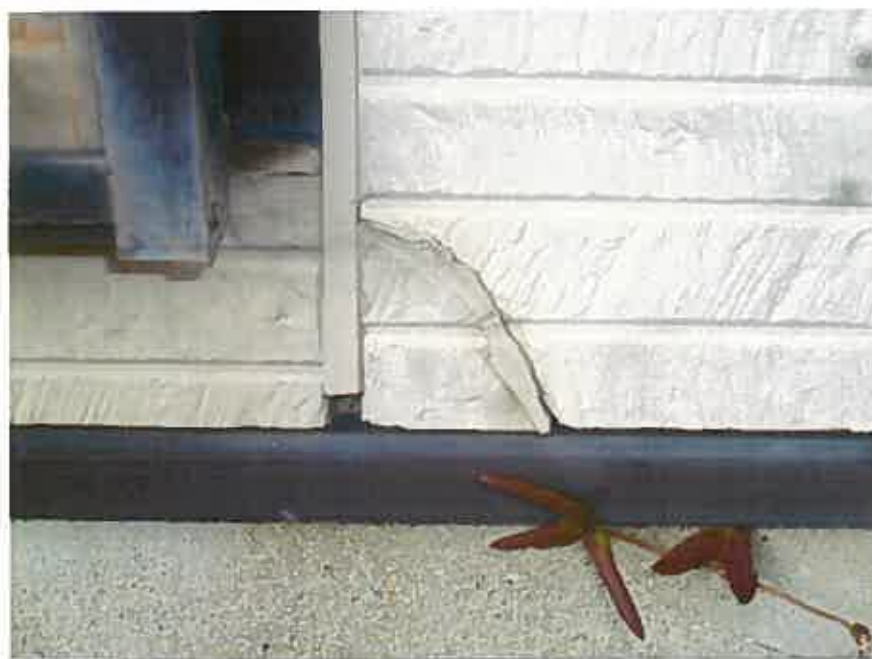
2 外壁の 損傷
