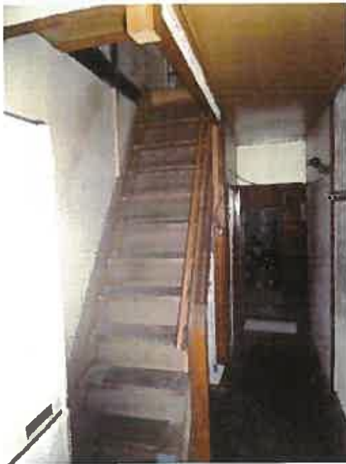
17 同上 廊下 及び 階段
