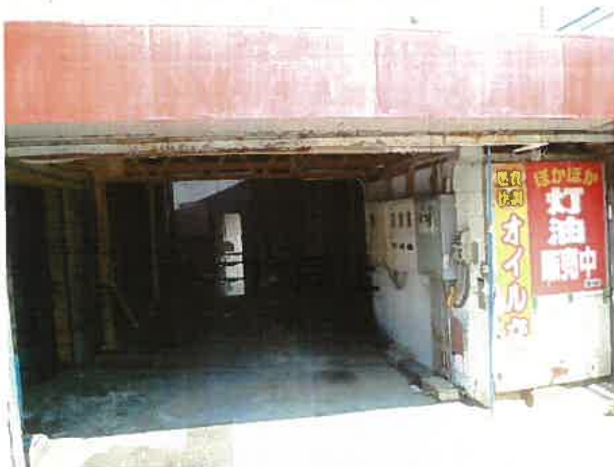
7 同上 ポンプ室
