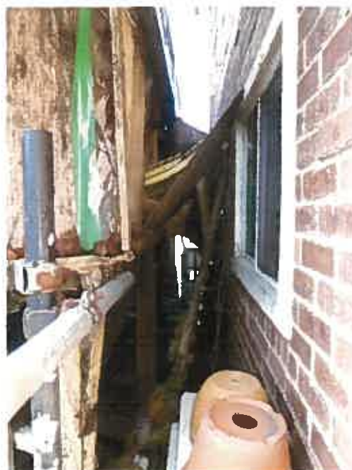
3 南側隣家 との間の 状況
