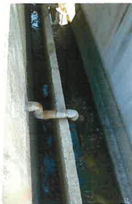
5 北側水路に 配水管が 出ている 状況
