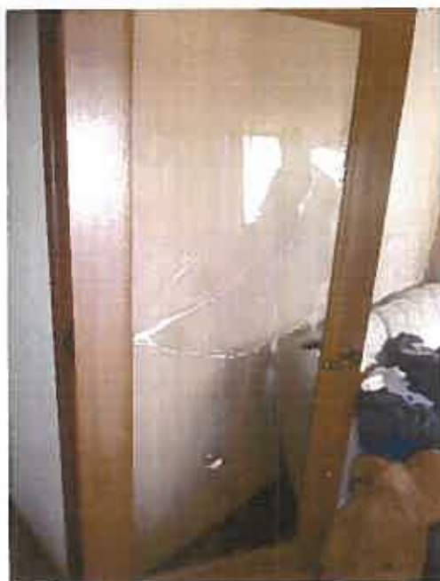
12 洋室2の 入口ドア
