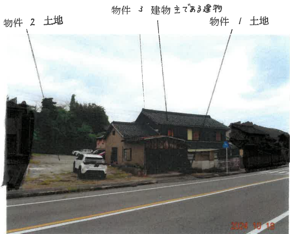
① 北東側から見た物件 1 土地、物件 2 土地及び物件 3 建物主である建物の状況
