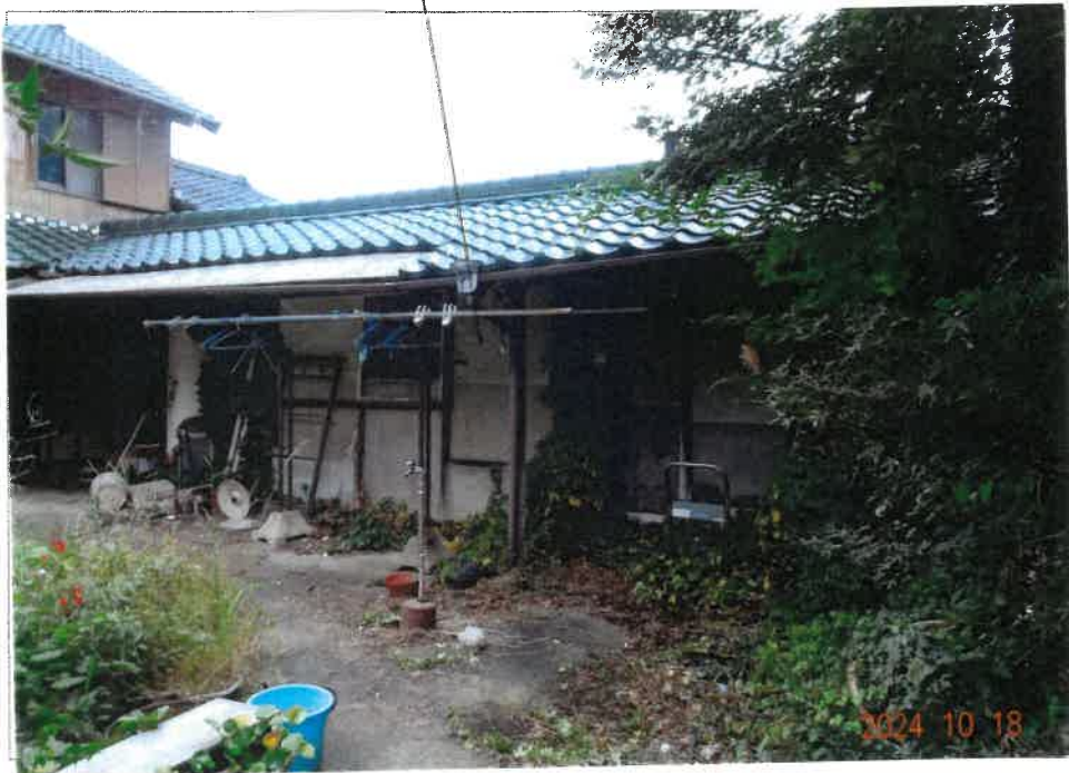
⑭ 物件 3 建物附属建物符号 1 の状況
