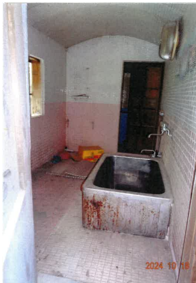
⑫ 物件3建物附属建物符号1屋内の状況（浴室）
