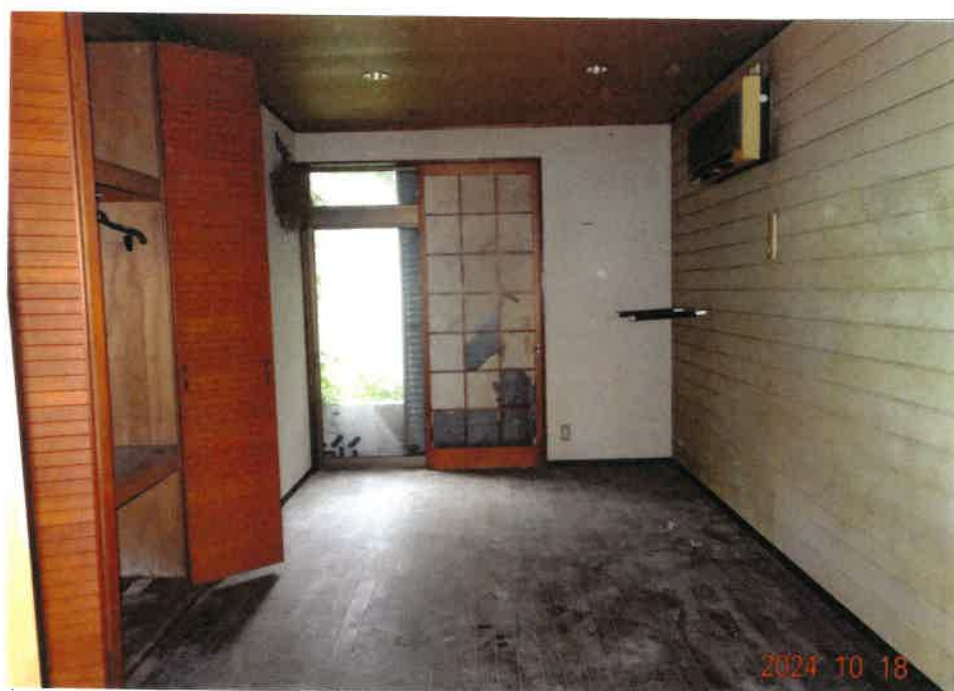
⑩ 物件3建物附属建物符号1屋内の状況（洋室 2）
