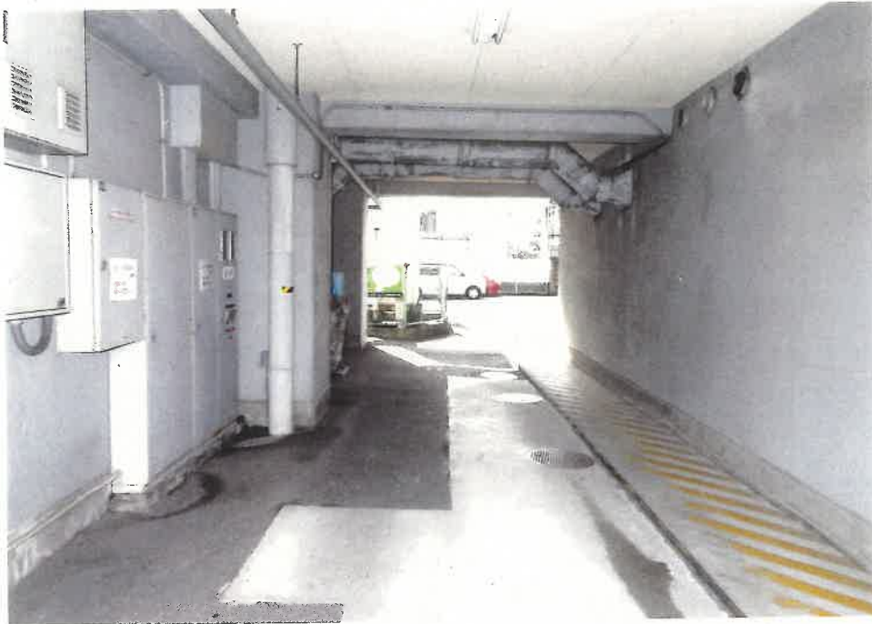
⑨ 駐車場から道路に通じる通路の様子
