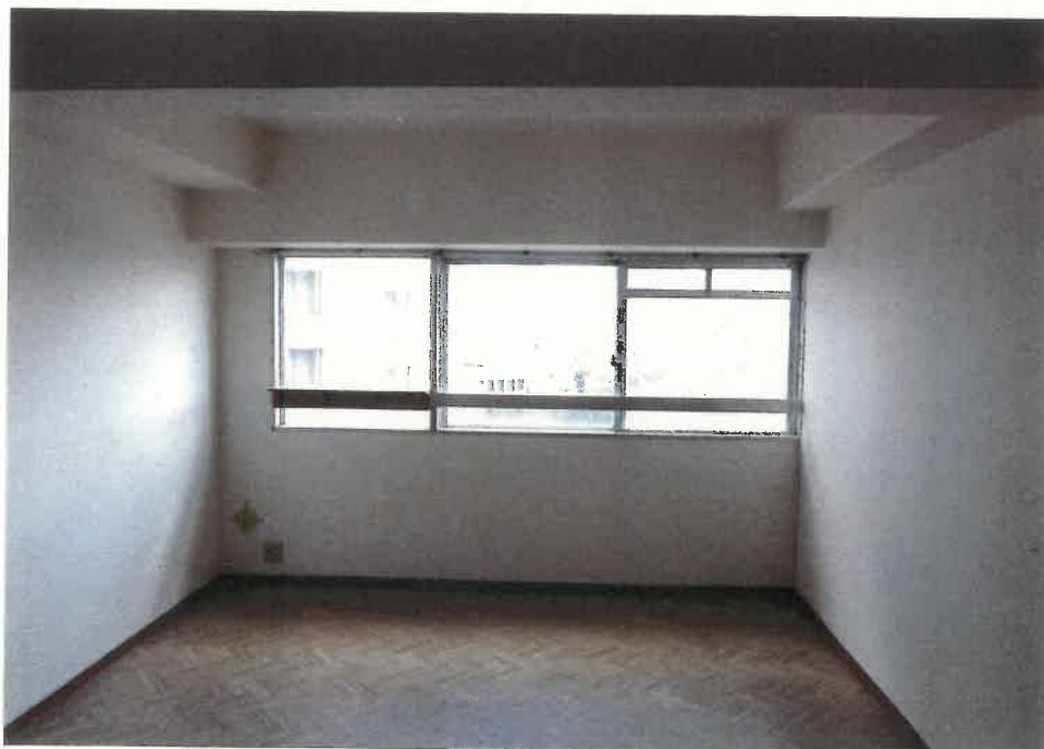
④ 屋内の状況（701号室リビング・ダイニングの様子）
