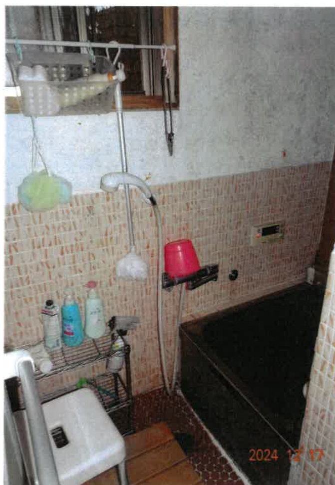
⑥ 屋内の状況（浴室）
