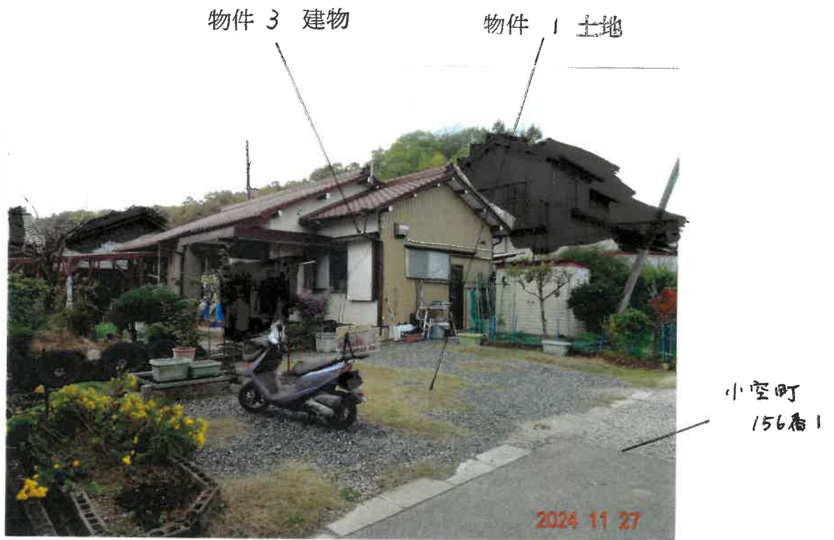
① 東側から見た物件 1 土地及び物件 3 建物の状況
