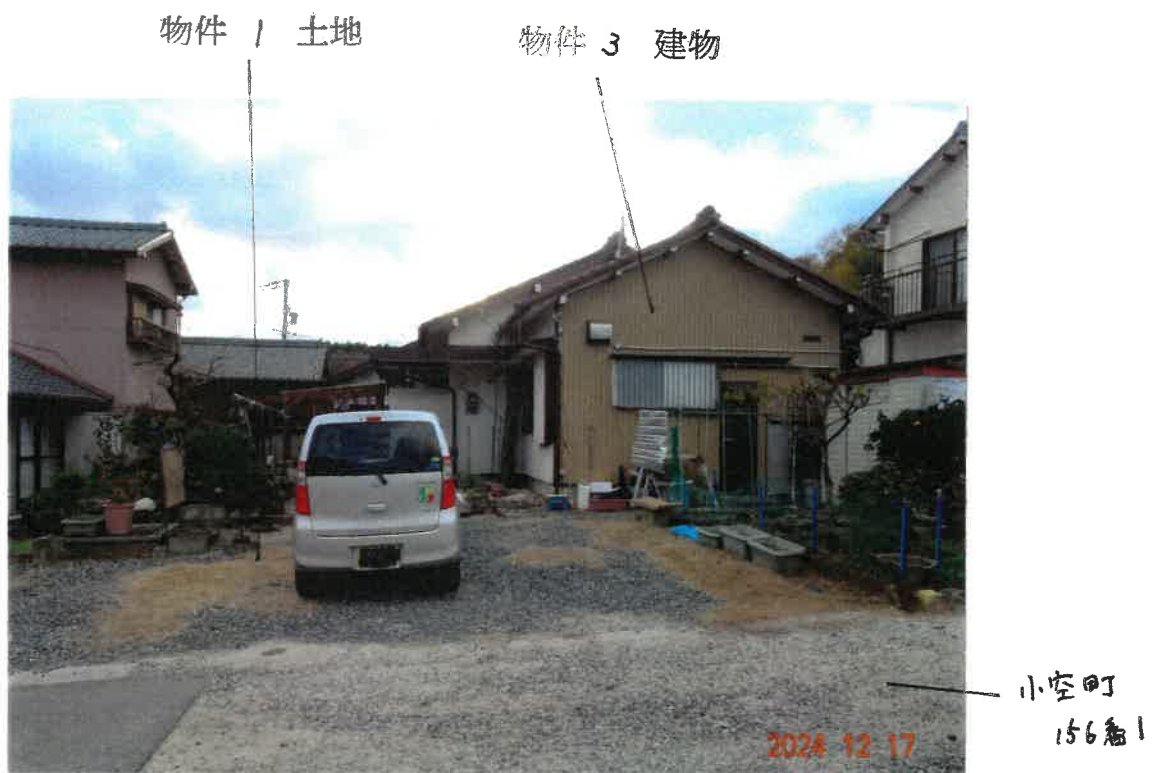
② 北東側から見た物件 1 土地及び物件 3 建物の状況
