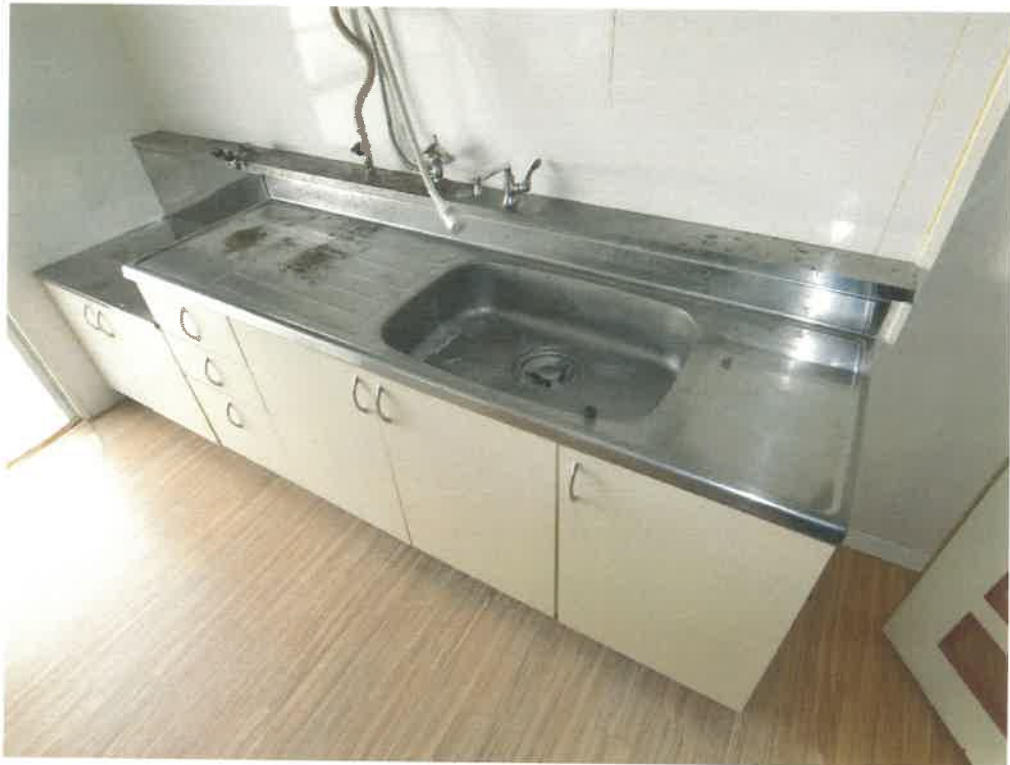
6 物件1建物内部の状況（キッチンシンク）
