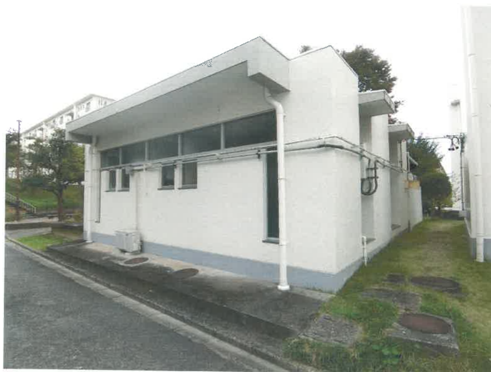
4 物件2建物の外観（北西方向から撮影）
