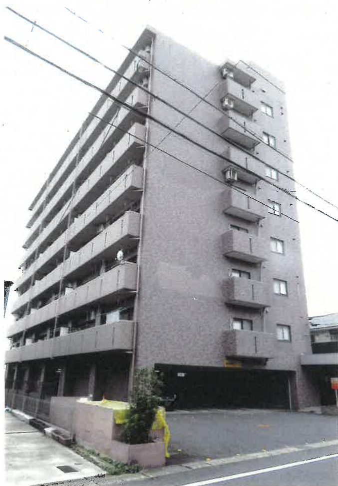
① 東方向から撮影
