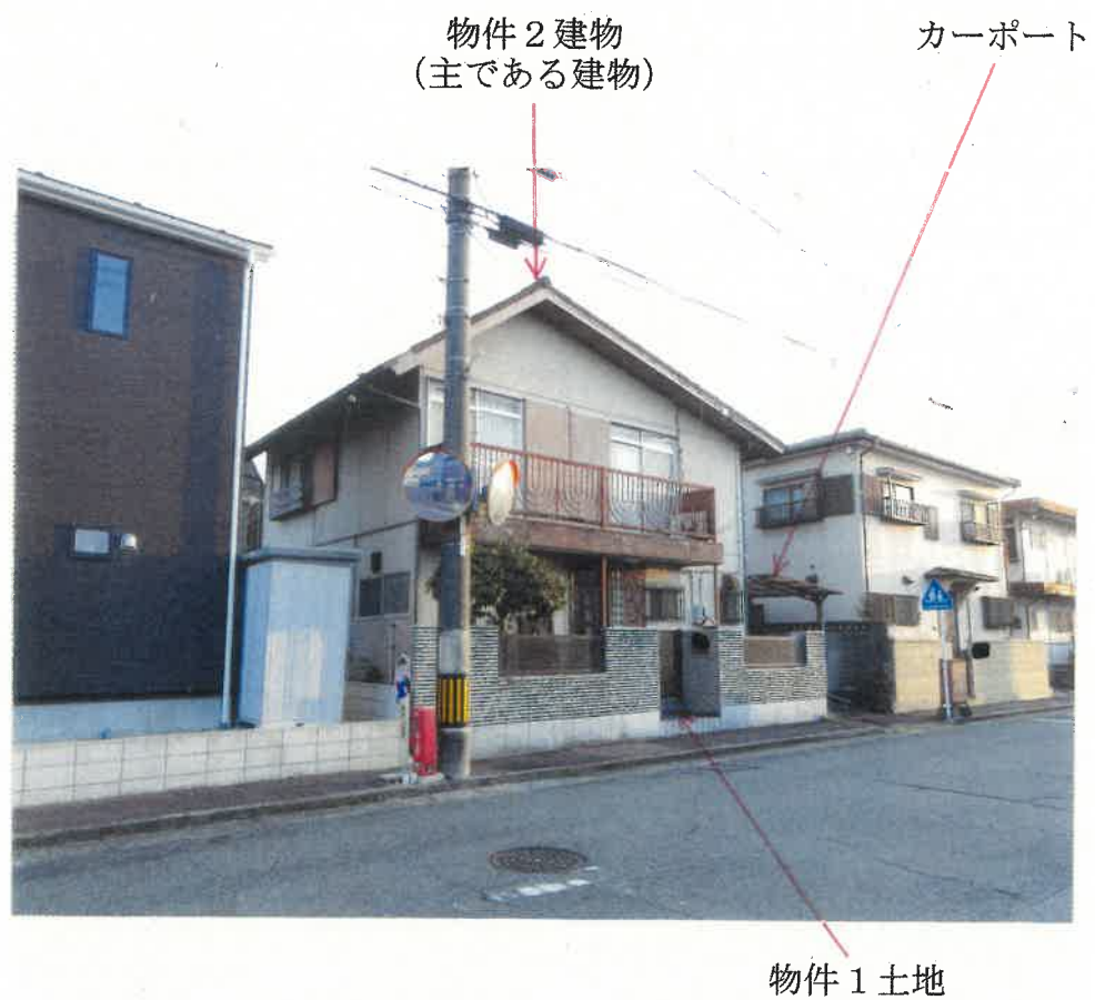
② 物件1土地、物件2建物の外観（北東方向から撮影）
