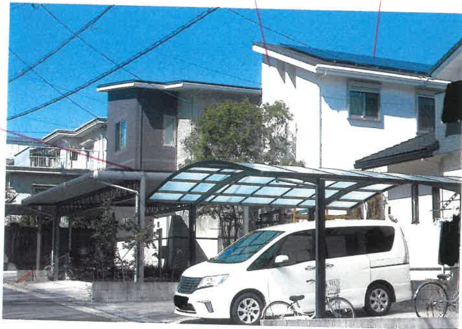
屋外の状況 (物件建物 ソーラーパネルの設置状況)
