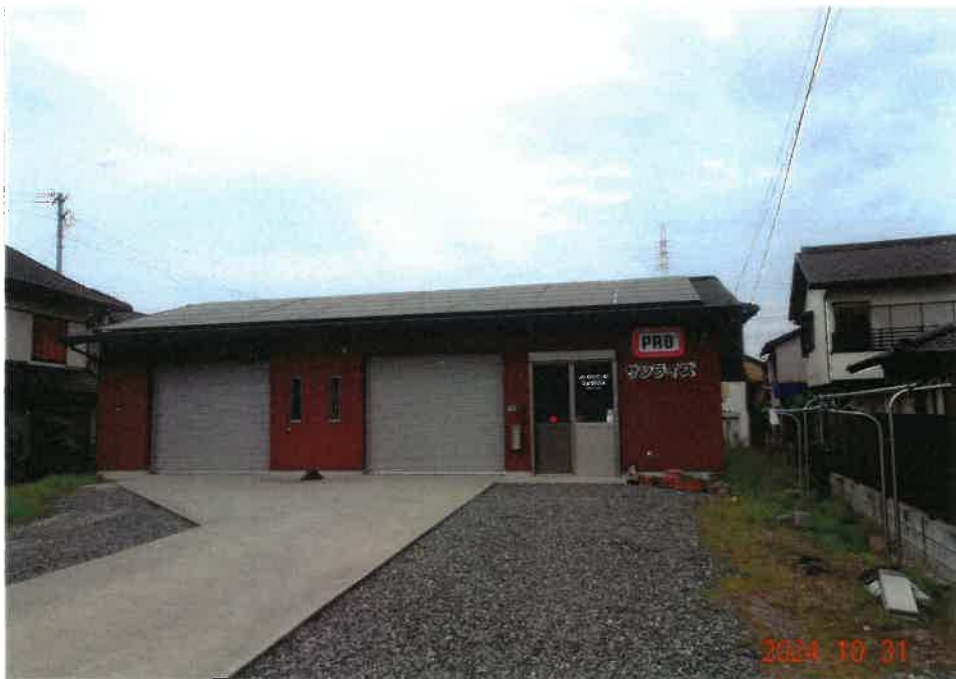
② 物件 7 建物の状況
