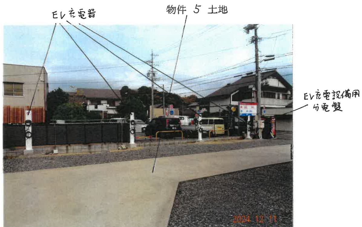
⑦ 物件 5 土地の北東側の状況
