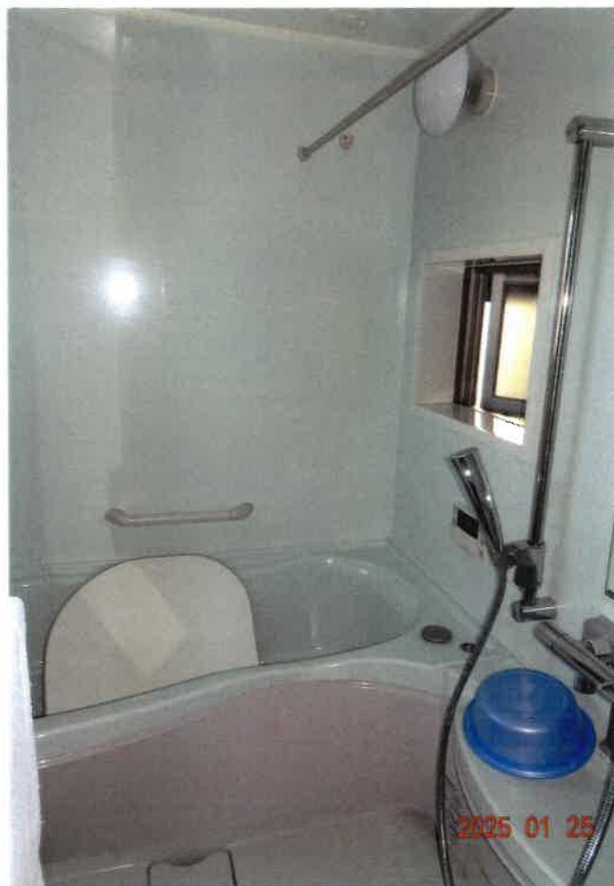
⑥ 物件3建物主である建物屋内の状況（1階 浴室）
