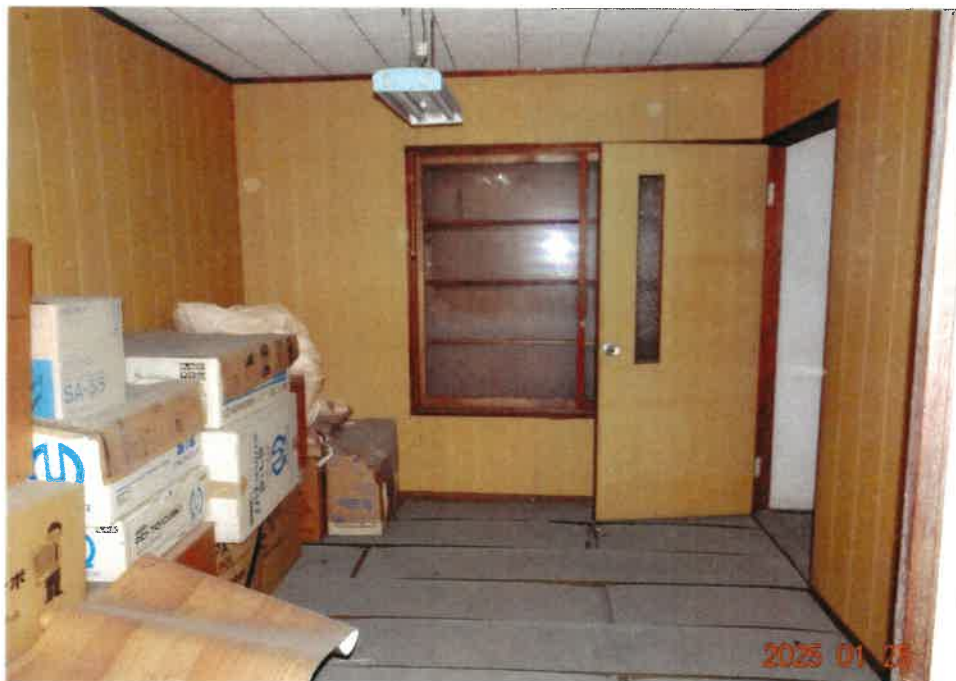
⑩ 物件3建物附属建物符号1屋内の状況（2階 板間 3）
