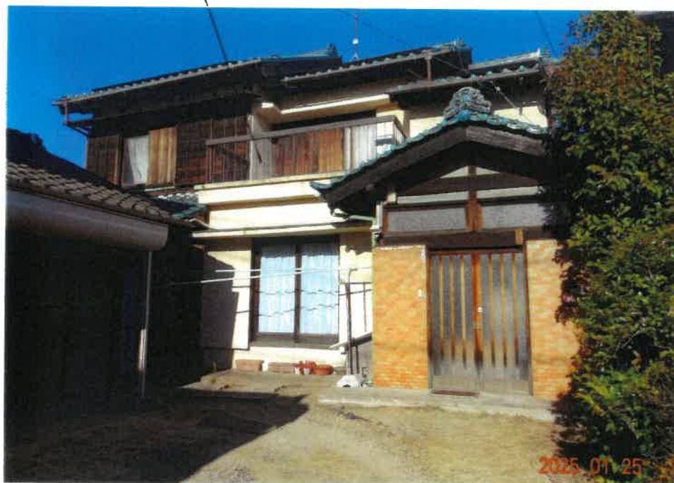
② 物件 3 建物主である建物の状況
