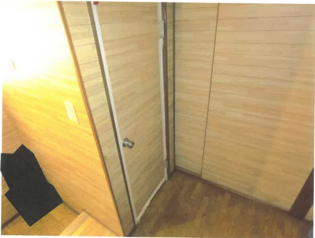
1 6 物件 2 建物内部の状況（ドアの目張り・2階トイレ）
