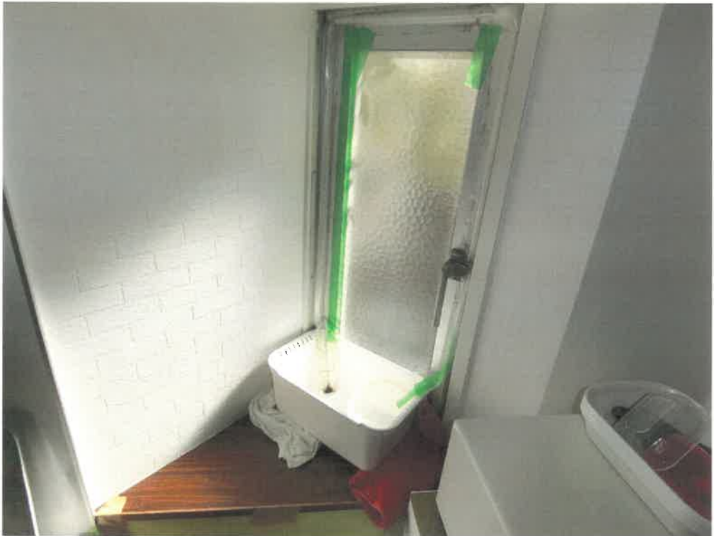
10 物件2建物内部の状況（キッチンシンク東側の小窓）
