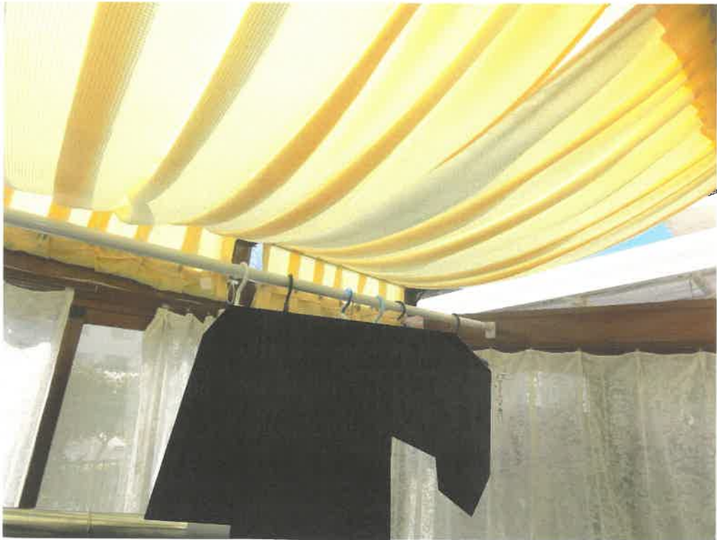
6 物件2建物内部の状況（サンルーム）
