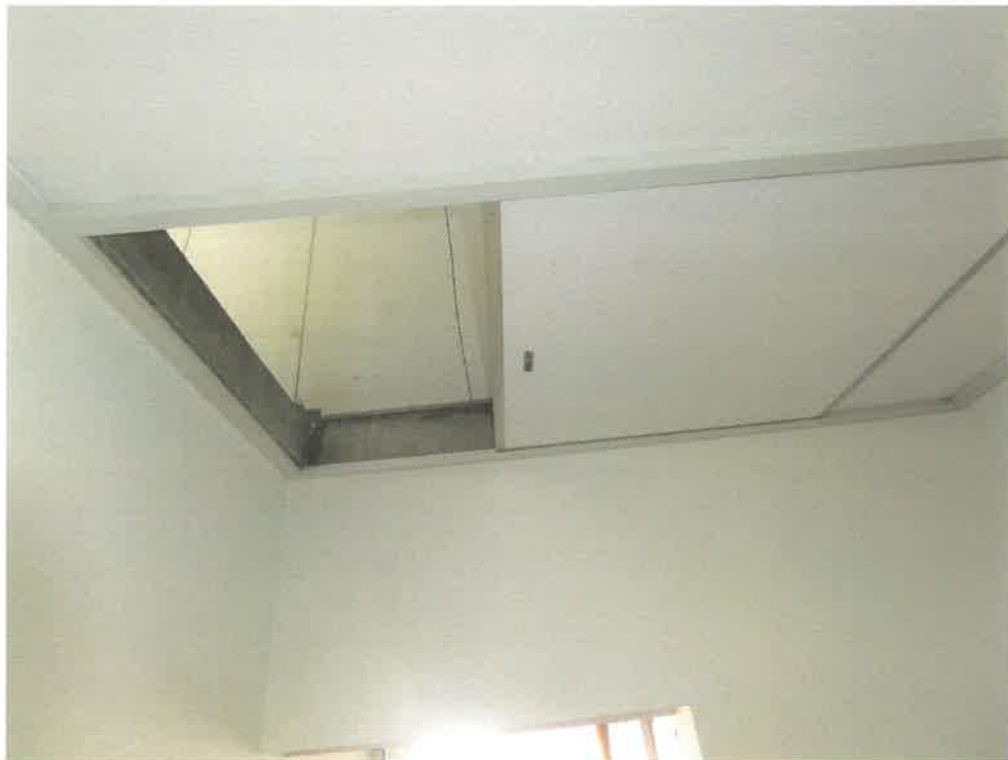
7 物件2建物内部の状況（小屋裏収納の昇降口）
