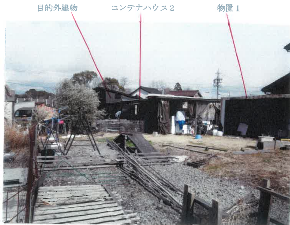
⑤ 物件2土地内の状況（南西方向から撮影）
