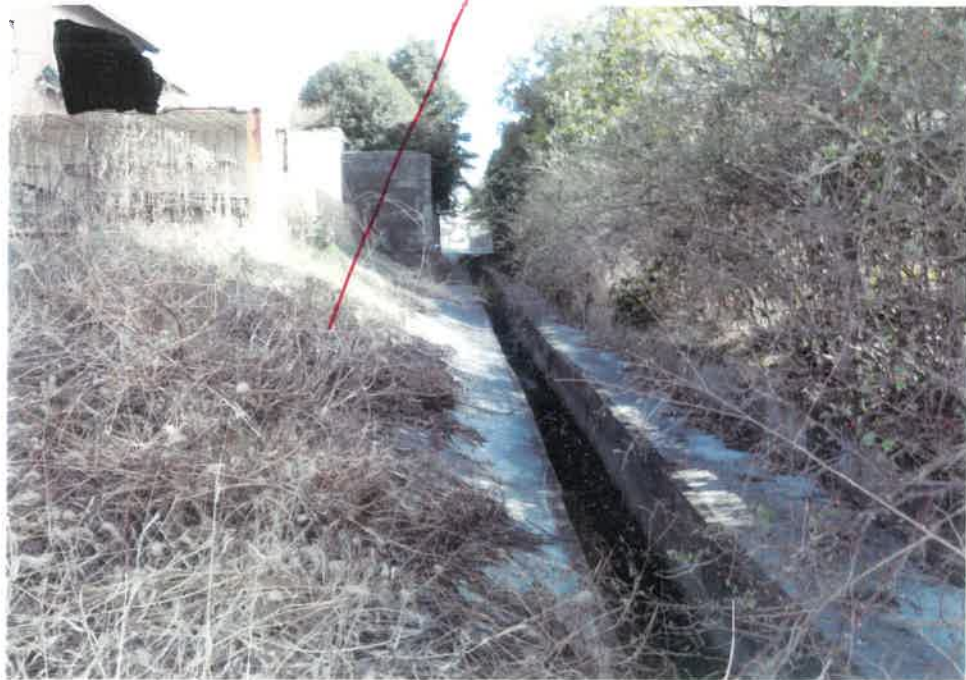
⑦ 物件2土地の南西側の状況
