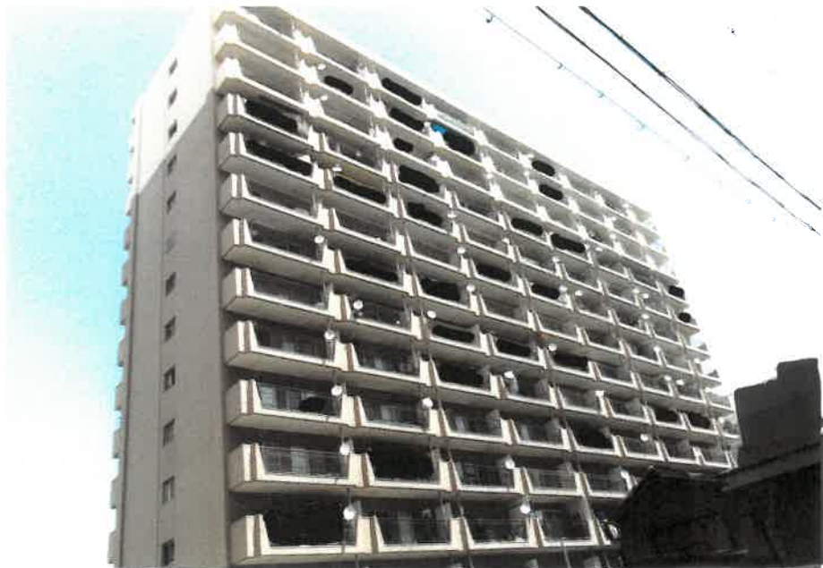
② 本件建物の外観（南西方向から撮影）
