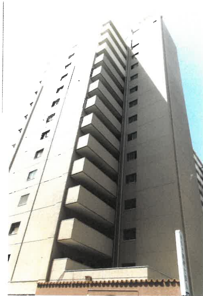
① 本件建物の外観（北東方向から撮影）
