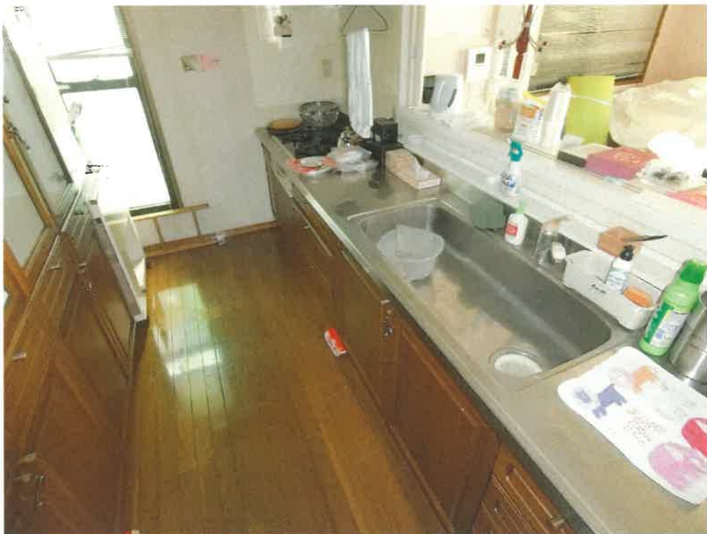
8 物件2建物内部の状況（K（キッチン））
