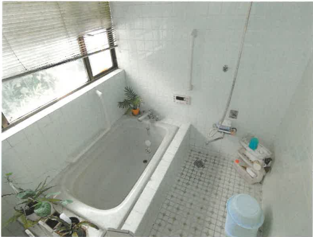
1 3 物件 6 建物内部の状況（浴室）
