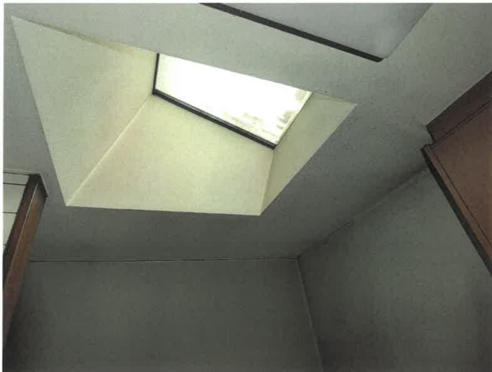
7 物件1建物内部の状況（トップライト・台所上部）
