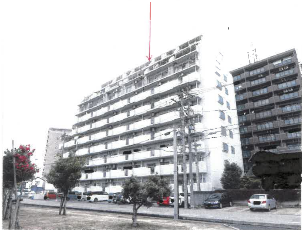
物件1建物を含む一棟の建物
