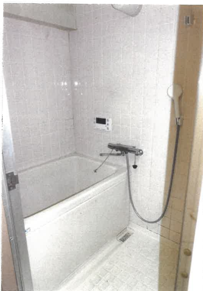
⑥ 屋内の状況（浴室）
