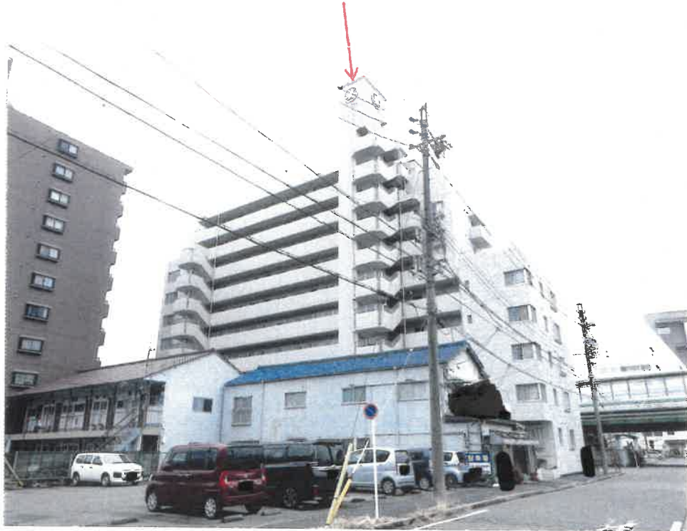
物件1建物を含む一棟の建物
