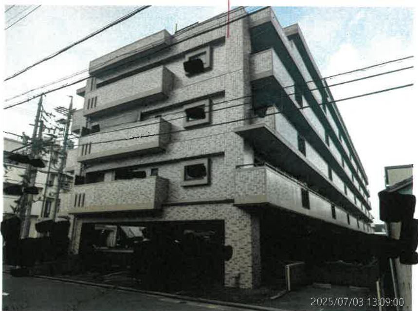
物件1 建物を含む一棟の建物 (宝マンション矢田)
