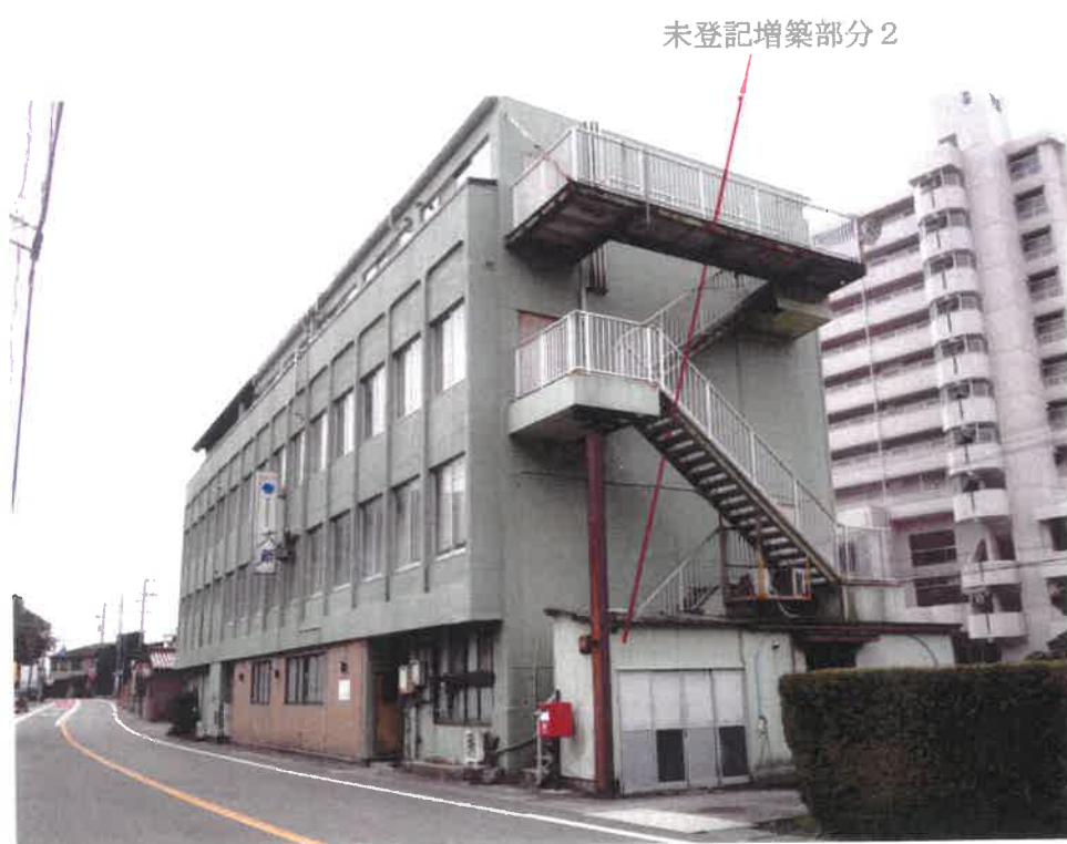
② 物件 1 1 建物の外観（ 北 南東方向から撮影）
