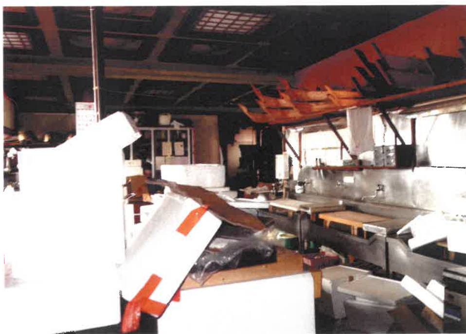
㊦ 屋内の状況（1階・厨房2）
