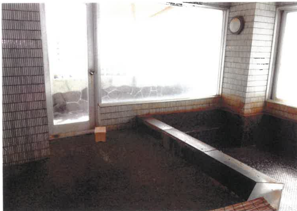
⑩ 屋内の状況（6階・大浴場1）
