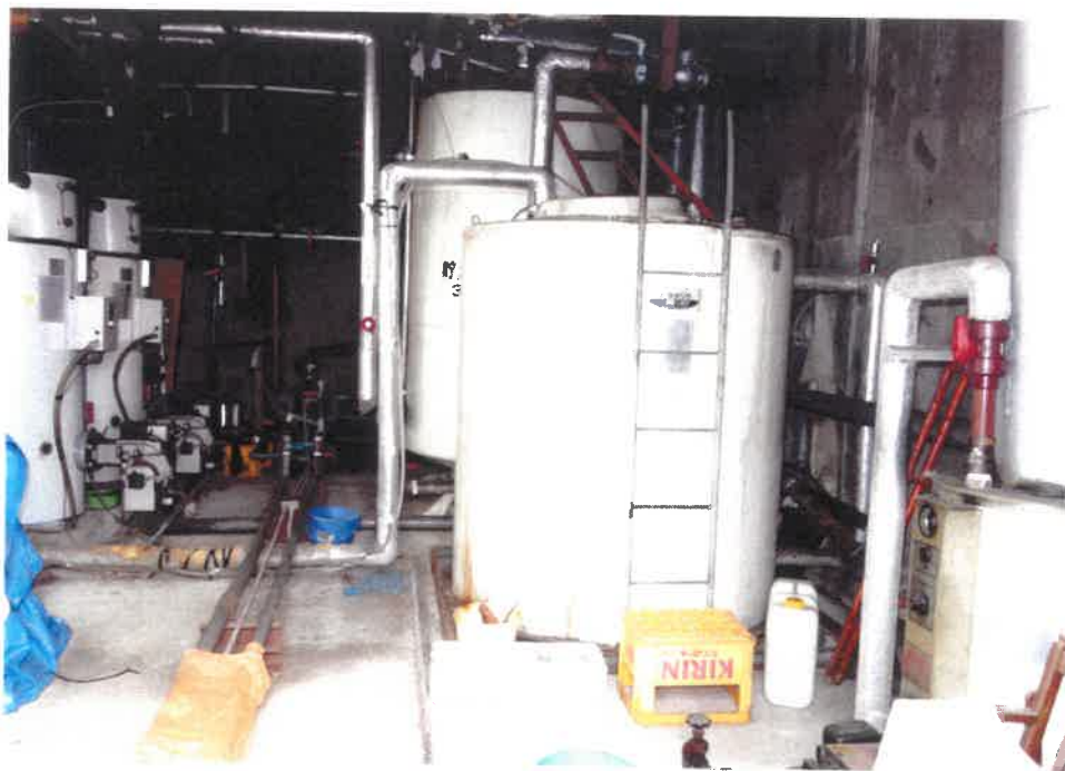
⑥ 屋内の状況（7階・ボイラー室）
