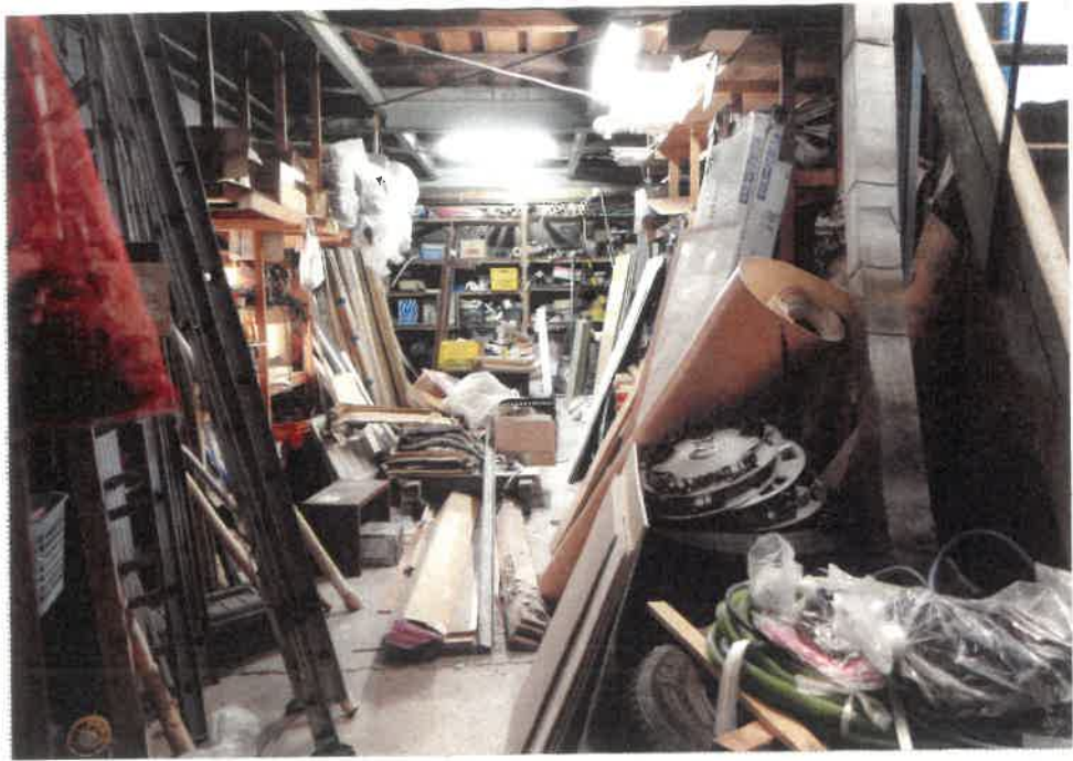
⑨ 屋内の状況（倉庫1）
