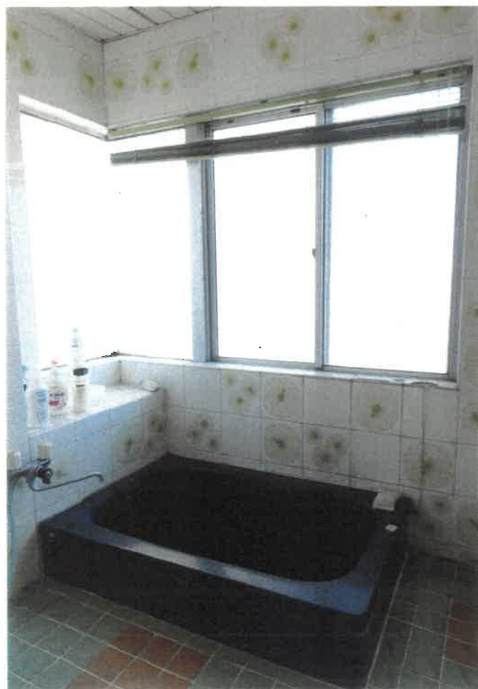
⑧ 屋内の状況（浴室）
