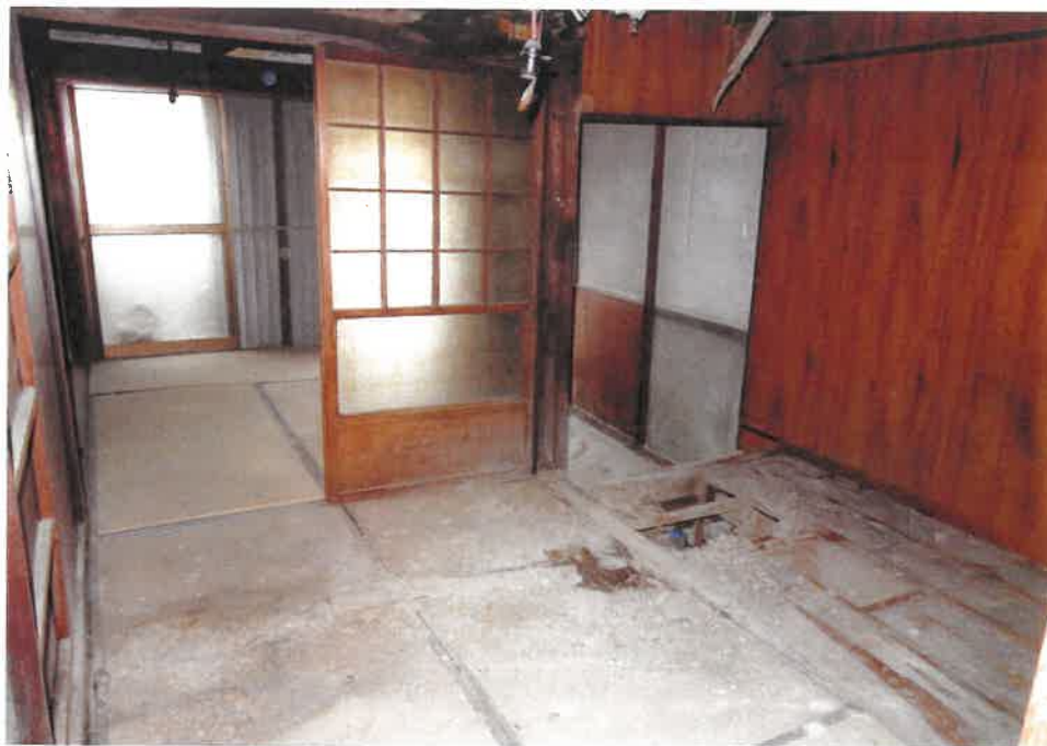
④ 屋内の状況（和室 3 畳から和室 4.5 畳 1 及び土間方向を撮影）
