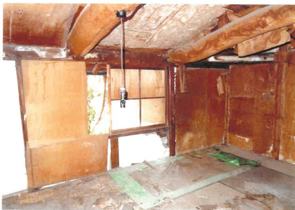
⑧ 屋内の状況（和室6畳2の窓と天井の様子）
