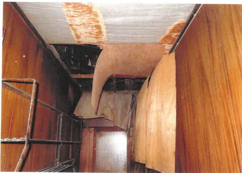
⑤ 屋内の状況（廊下天井部分を撮影）
