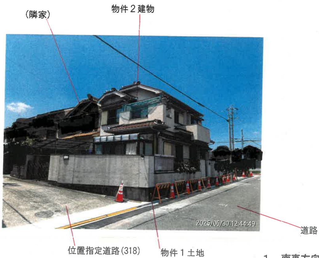
1 南東方向から撮影
