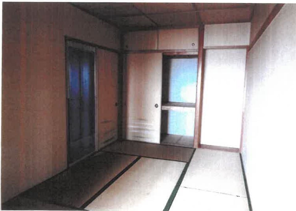
② 屋内の状況（和室）
