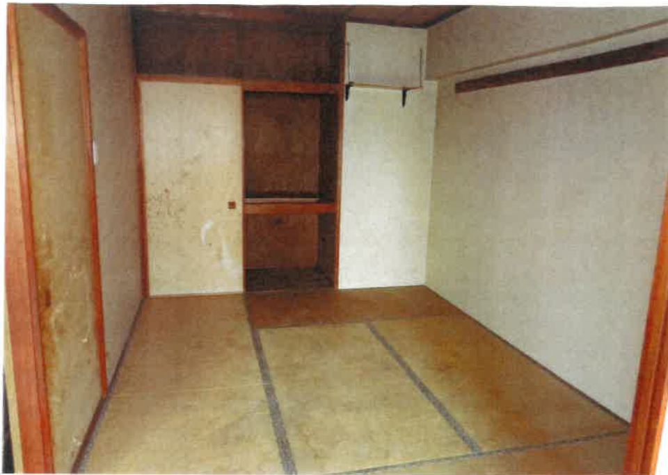
③ 屋内の状況（和室）
