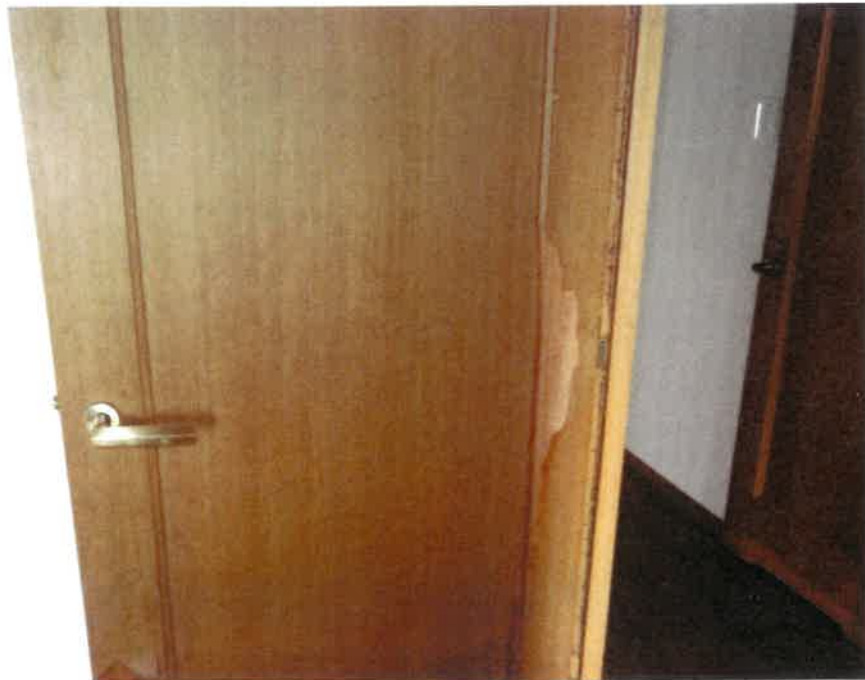
⑥ 屋内の状況（洋室①の扉の様子）
