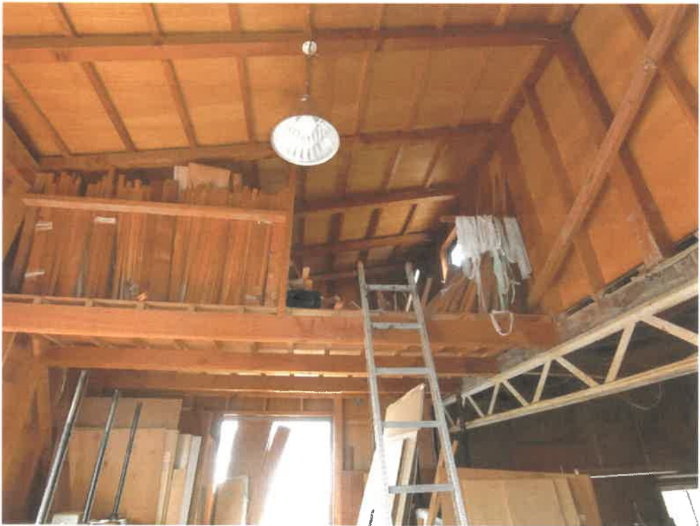
6 物件1主である建物内部の状況（物置2）
