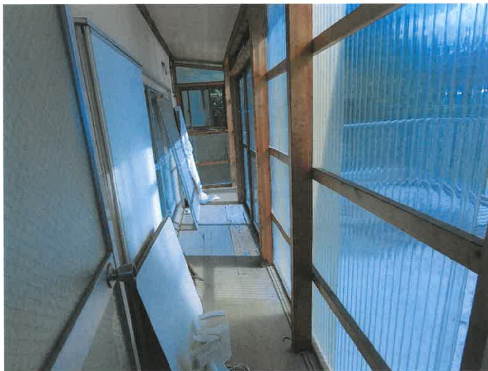
8 物件4建物内部の状況（2階サンルーム）
