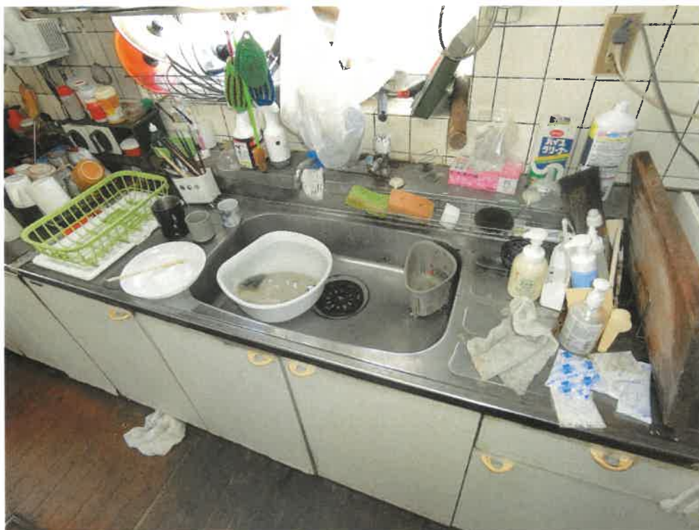
6 物件4建物内部の状況（キッチンシンク）
