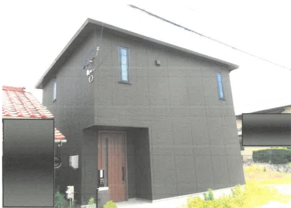
② 物件1及び2土地を含む物件3建物の外観
