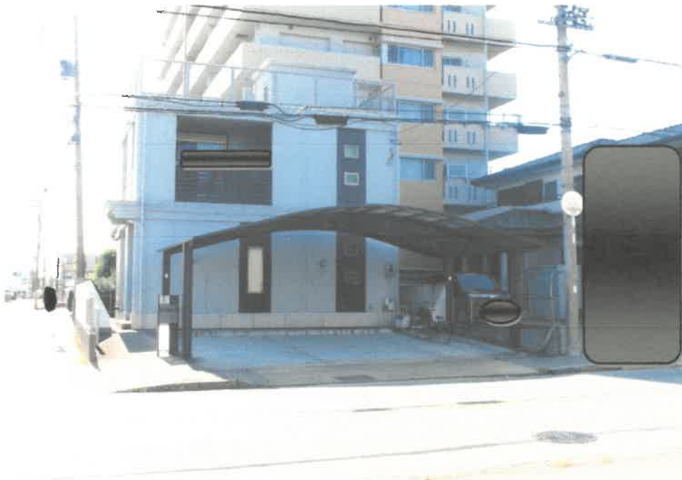
① 物件1、2土地を含む物件3建物の外観
