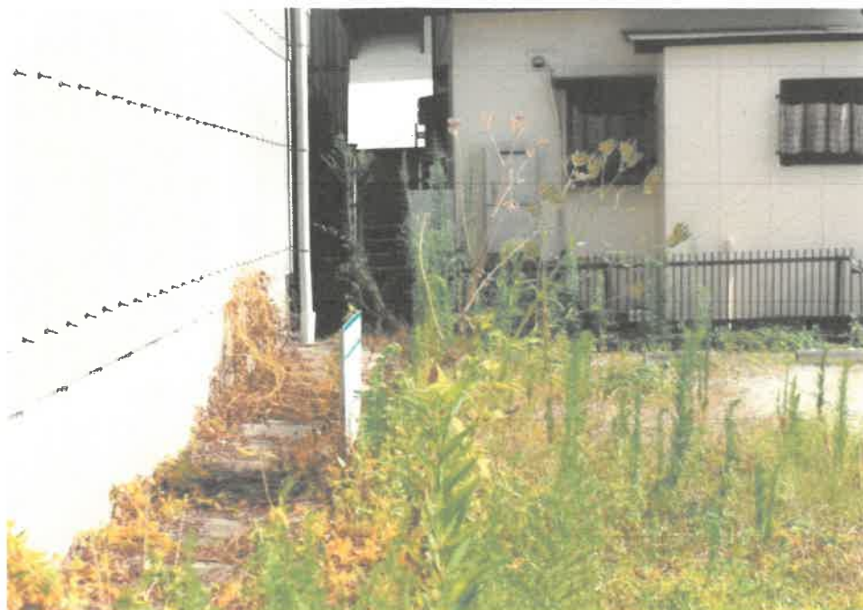
⑤ 物件1、2土地東側の状況
