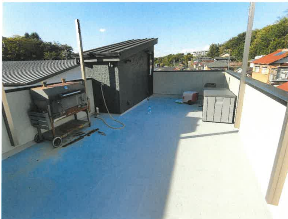
7 物件2建物の塔屋及び屋上バルコニー
