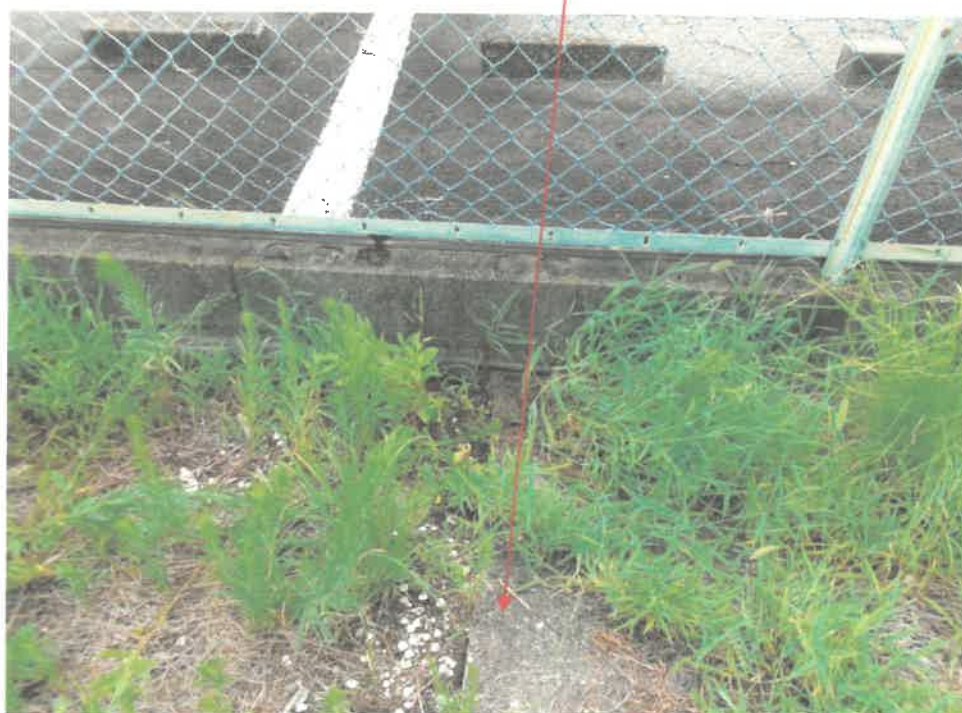
⑯ 物件4土地旗地南西の境界付近の状況
