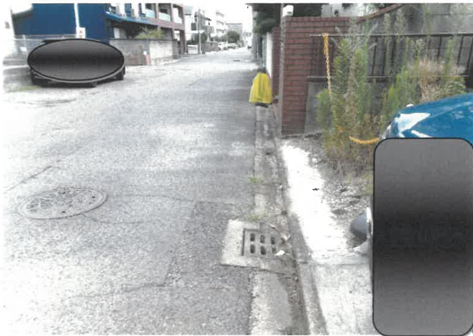
⑤ 物件4土地北側の状況
