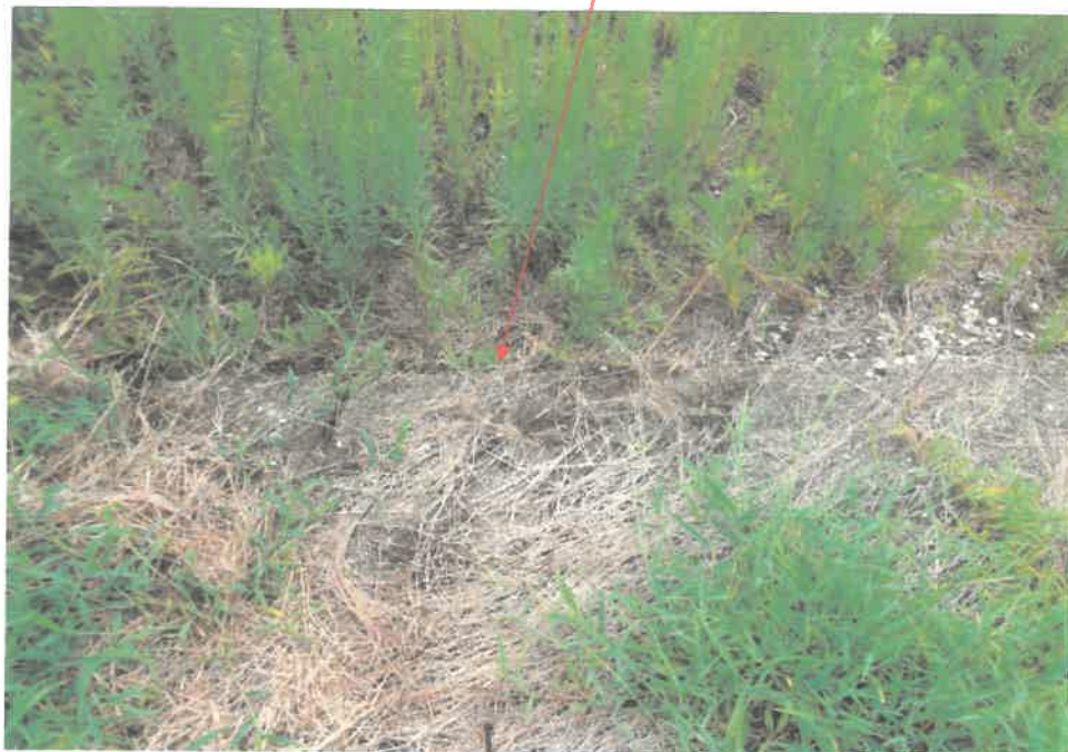
⑮ 物件4土地南側敷設のコンクリートの状況
