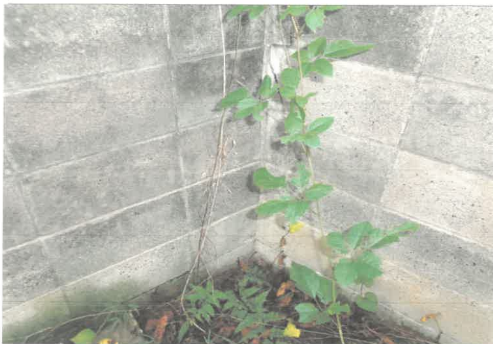
⑨ 物件1土地の南西角の状況
