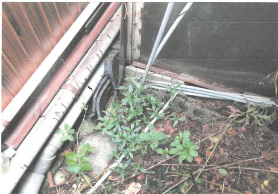
⑪ 物件1 土地の西角の状況
