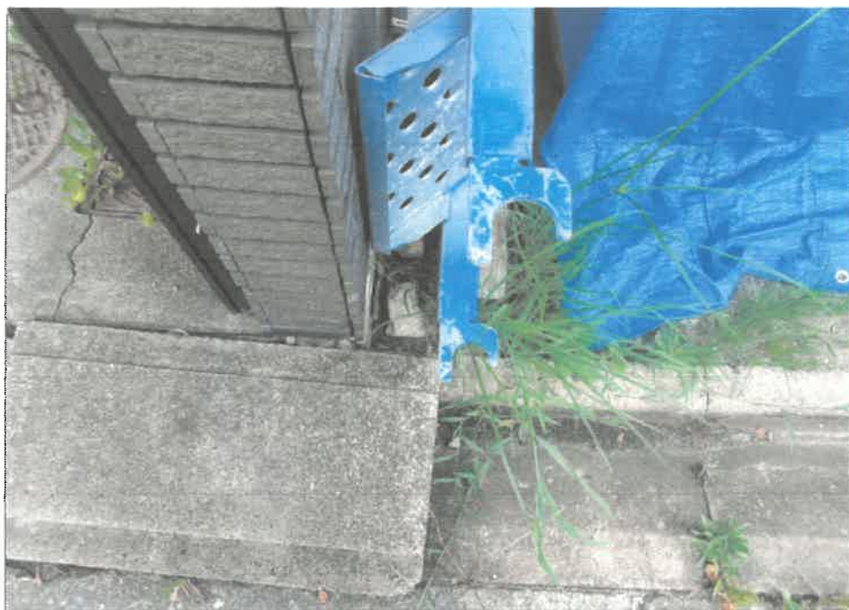
③ 物件1 土地北東の境界の状況
