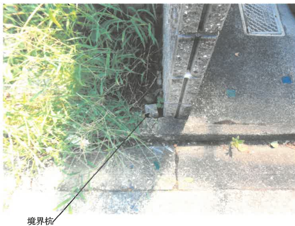
② 物件1土地北西の境界の状況
