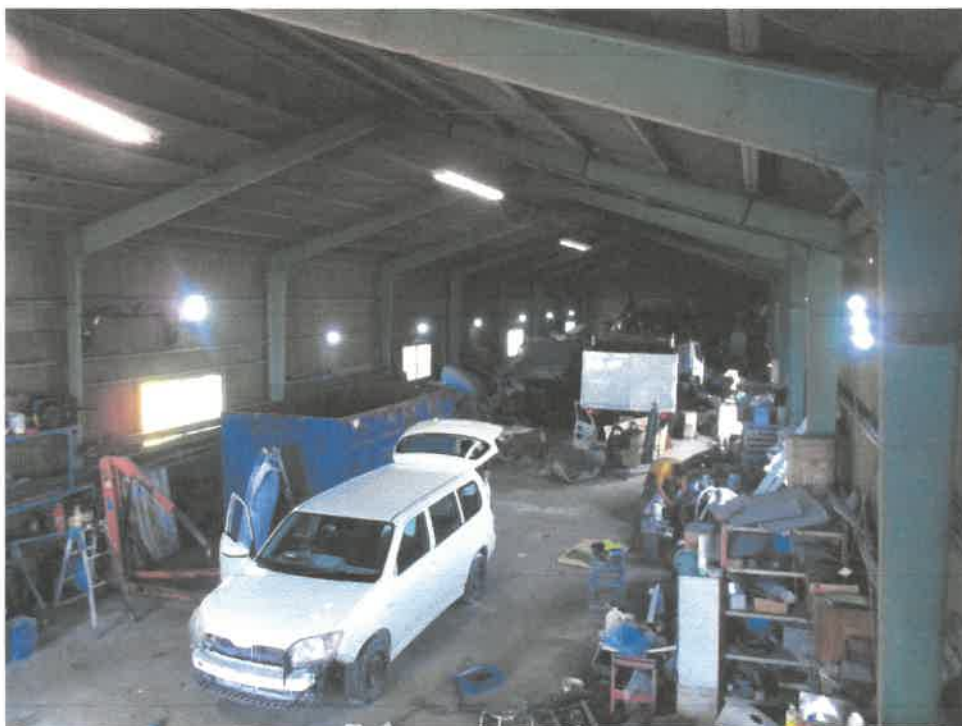
④ 物件2建物内全体の状況
