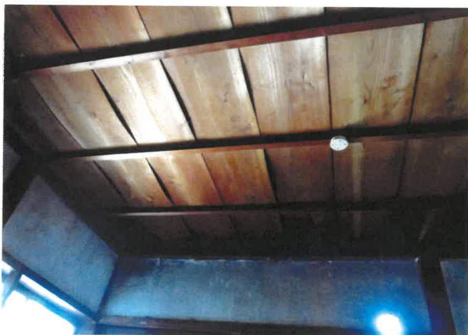
⑫ 屋内の状況（物件１４建物納戸の天井の様子）
