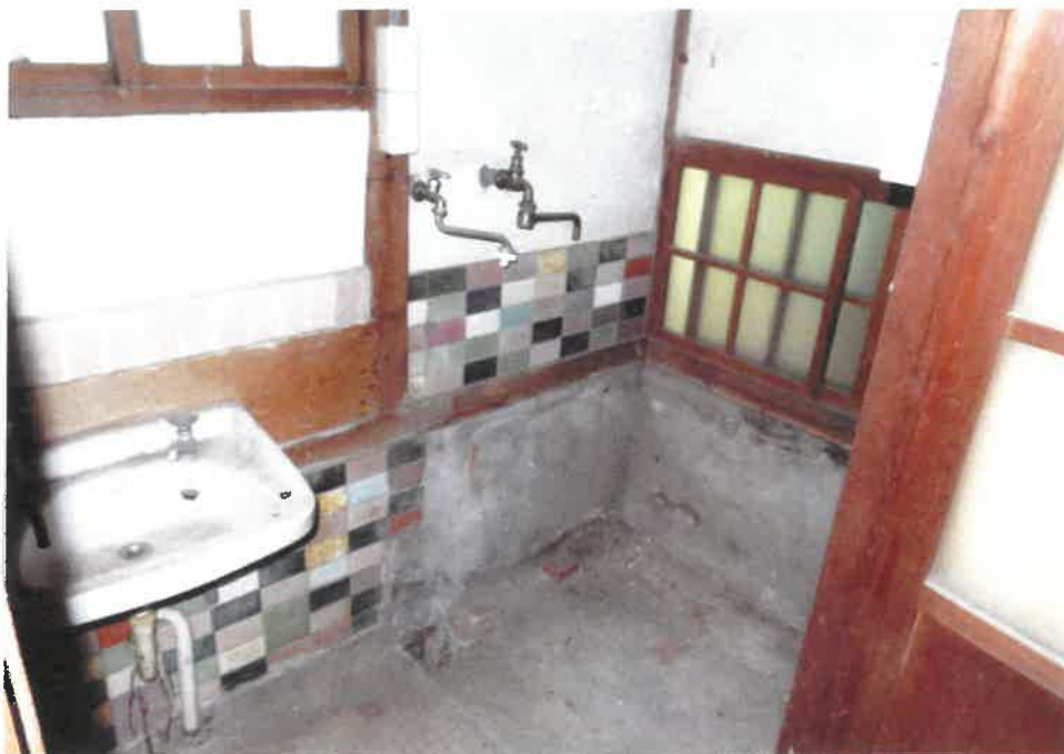
⑪ 屋内の状況（物件１４主である建物洗面所）
