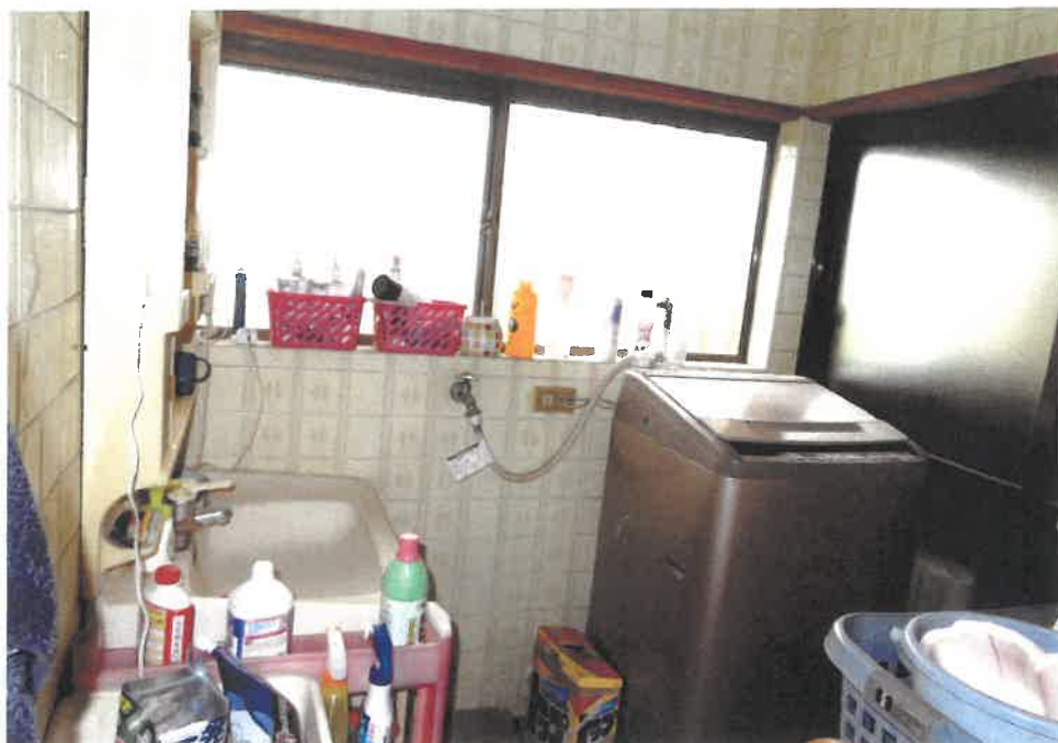
⑦ 屋内の状況（洗面所）
