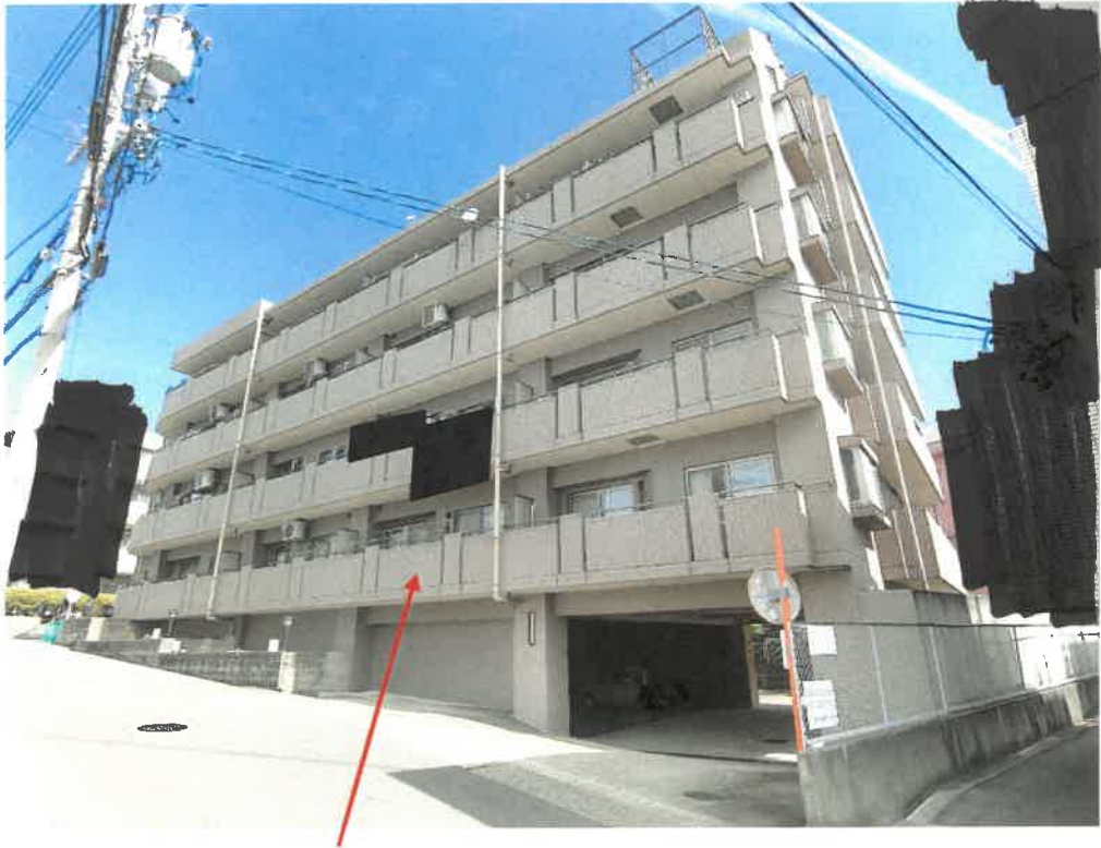
物件1建物を含む一棟の建物 (ユニーブル本郷南)
