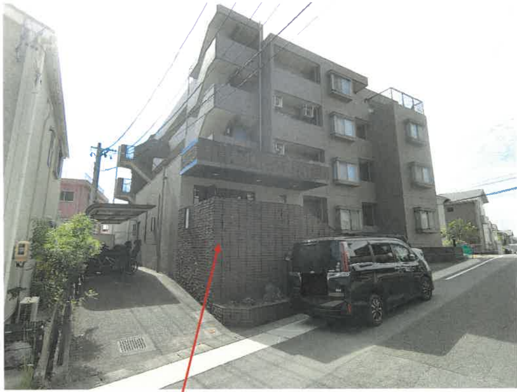
物件1建物を含む一棟の建物 (ユニーブル本郷南)
