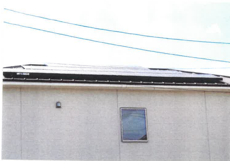
⑩ 太陽光パネルの様子
