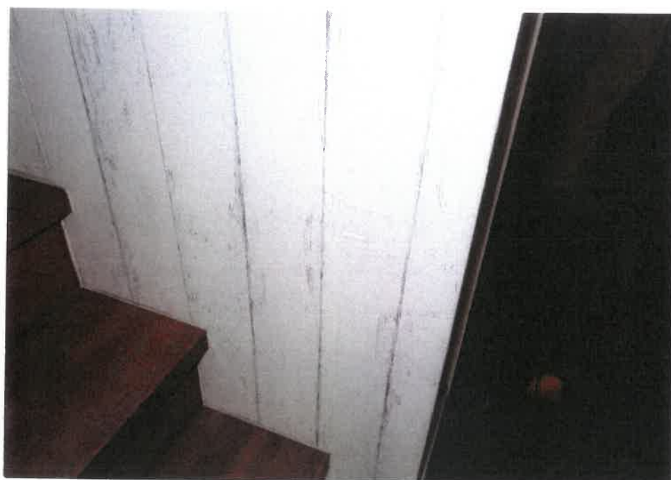
⑥ 1階階段付近のクロスが張り替えられている様子
