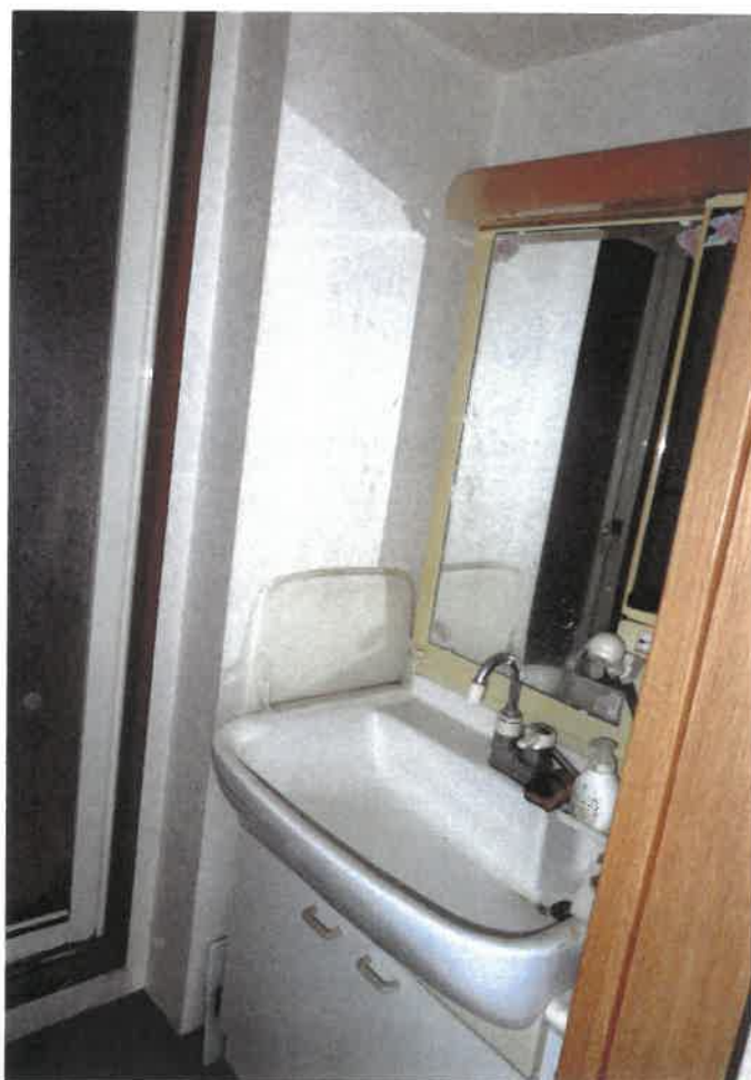
⑧ 屋内の状況（洗面所の様子）
