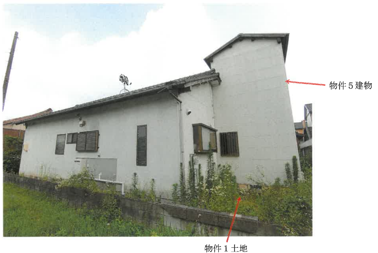
2 物件1土地及び物件5建物の外観（北西方向から撮影）
