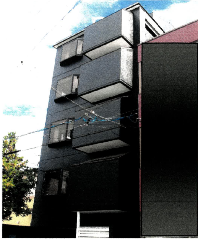
① 物件2及び3建物の存する一棟の建物の外観
