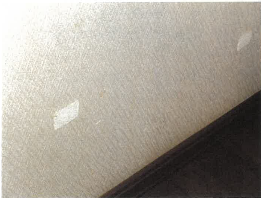
⑧ キッチンカウンターの壁の補修の状況
