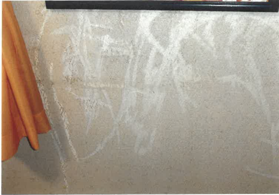
⑦ ダイニング壁の落書きの修復の状況
